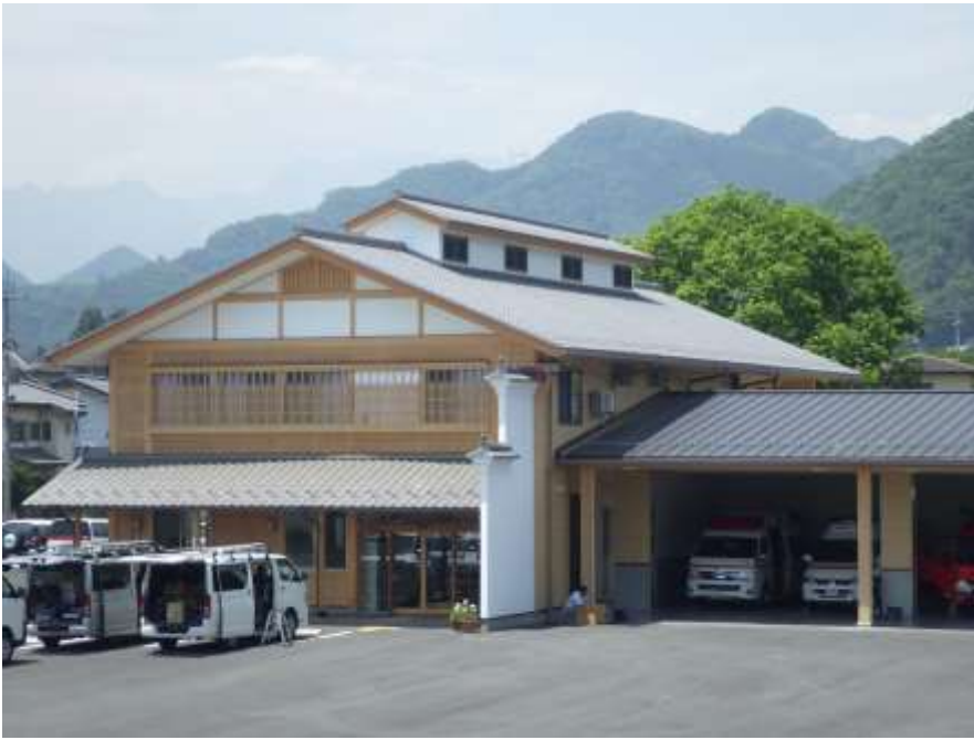
↑ 西分署(小鹿野町内H27.2完成)
