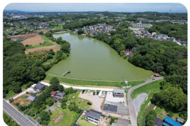
農地防災事業(ため池等整備) 大沼(大)地区
