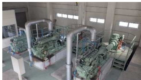
補修整備された排水ポンプ （吉見町 南吉見排水機場地区）
