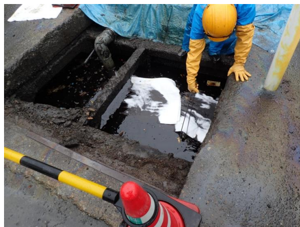
写真1 油回収作業の様子
