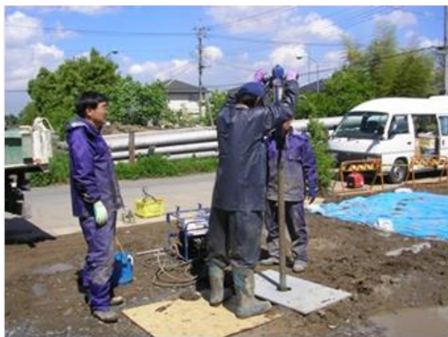
図 4 周辺観測井戸設置作業
