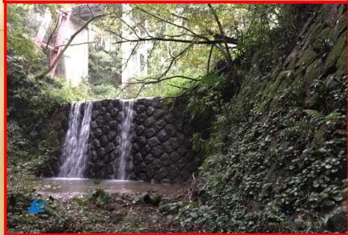
現場1：S9 堰堤(練石積) L=37.0m H=5.0m
