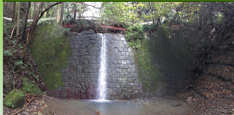
大正5年施工 砂防堰堤(切石積)
