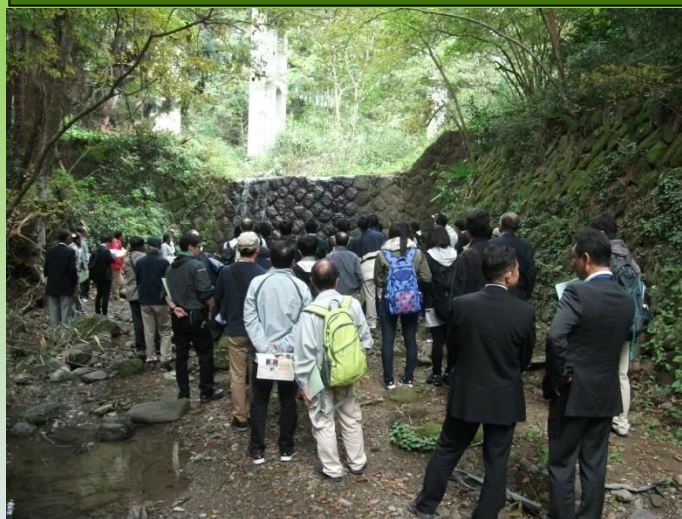
昭和9年施工 砂防堰堤(練石積) 説明
