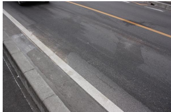
マンホールの固定が不完全であったため発生した流出事故の例
