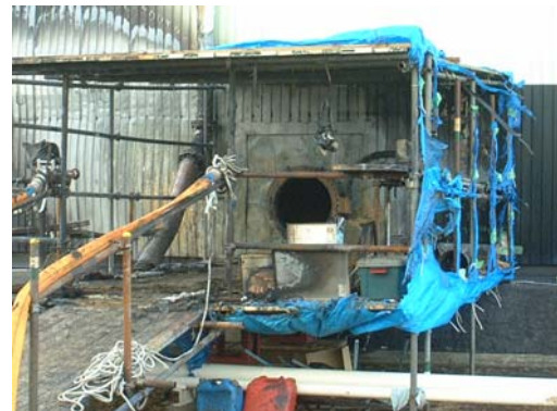
屋外タンク貯蔵所清掃中の火災事例
