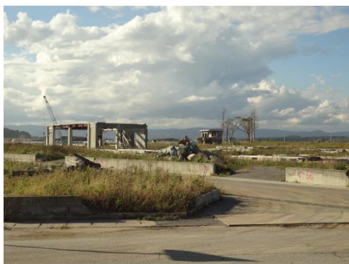
ガレキ撤去中の浪江町請戸地区
