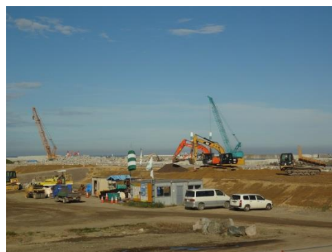
海岸災害復旧事業により8.7mの高さに整備された
