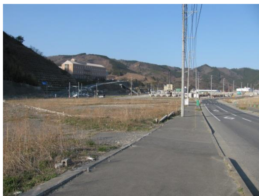
③壊滅した女川町市街地（H26.4月）
