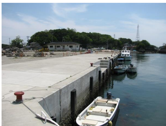
①災害復旧後の野々島漁港岸壁(H28. 10月)
