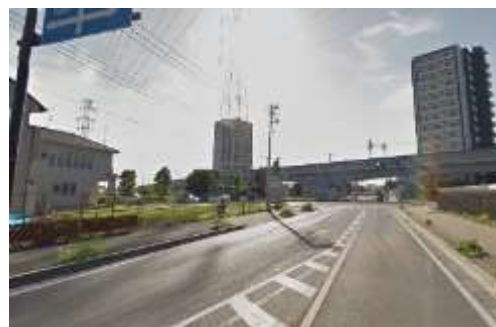
土地区画整理事業により 整備された都市計画道路
