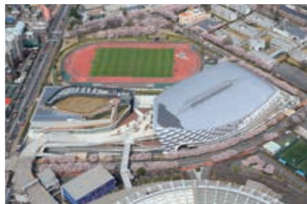
22 武蔵野の森総合スポーツプラザ ■バドミントン/近代五種[フェンシング] ▲車いすバスケットボール
