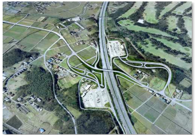
関越道寄居スマートインターチェンジ周辺
