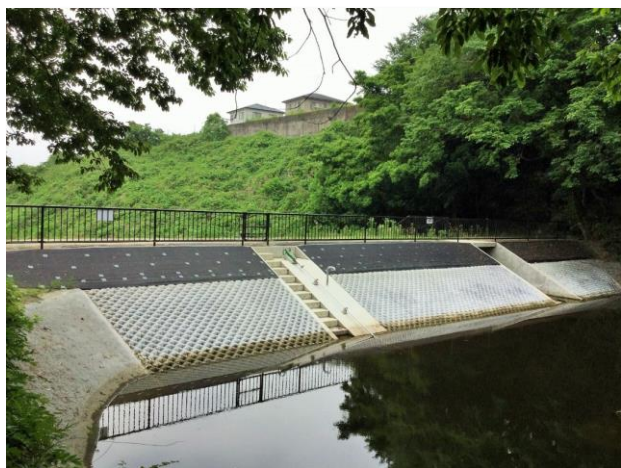
ため池の改修工事による防災機能強化
