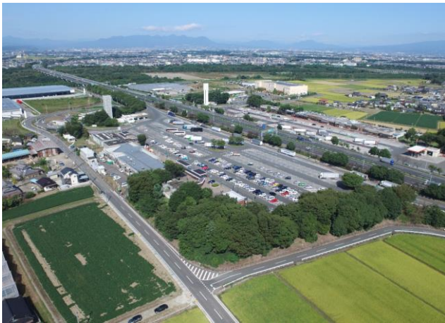
関越道上里S A周辺
