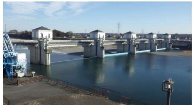
▲現在の六堰頭首工
