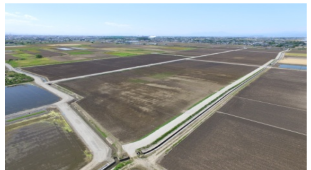
工事後（R1.5撮影）
