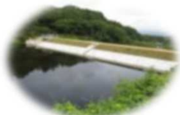
老朽化した堤体を補強
