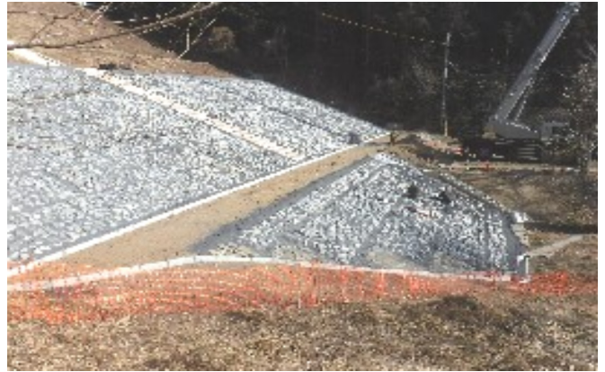
▲ 施工中（堤体裏面 石張工）
