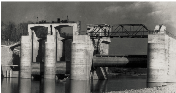
▲ 旧六堰頭首工
