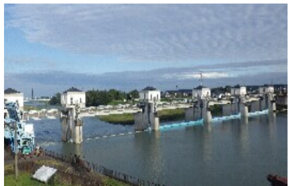
▲ 現在の六堰頭首工
