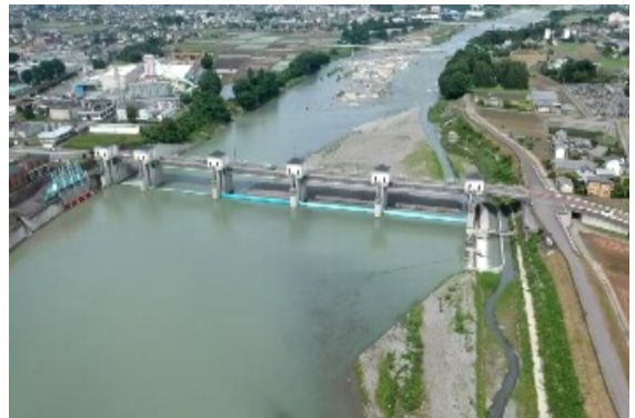
▲ 六堰頭首工 上空から
