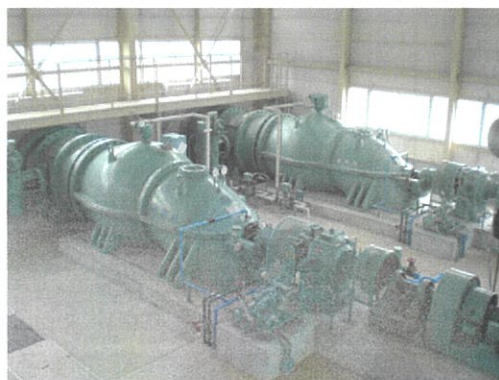
▲ 補修を行った奈良川排水機場のポンプ設備
