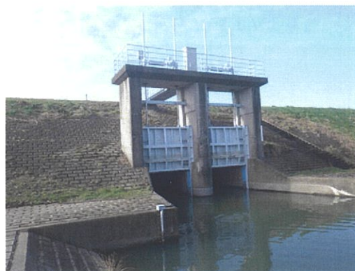
▲ 塗装を行った奈良川排水機場のゲート
