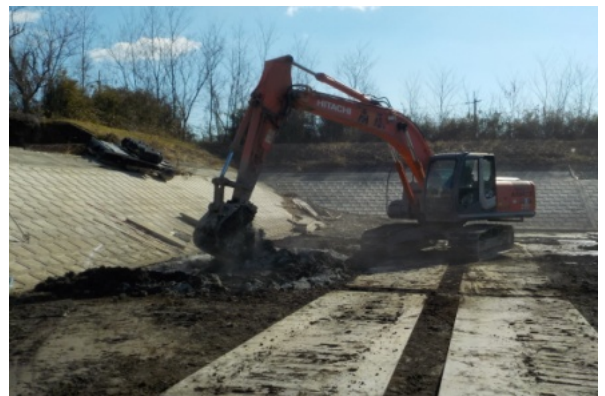
▲ 堤体の根元の地盤改良の様子
