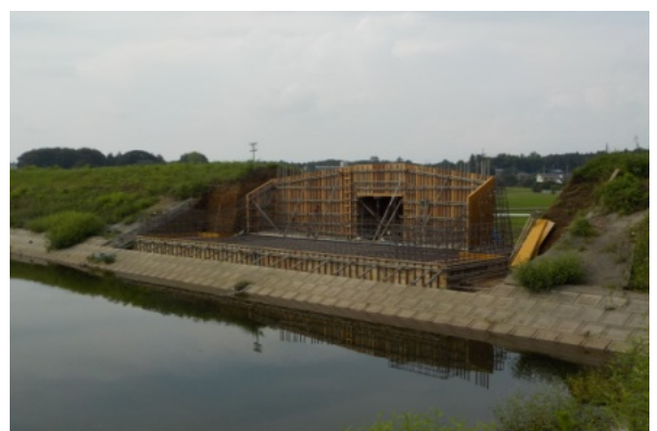
▲ 洪水吐の改修の様子
