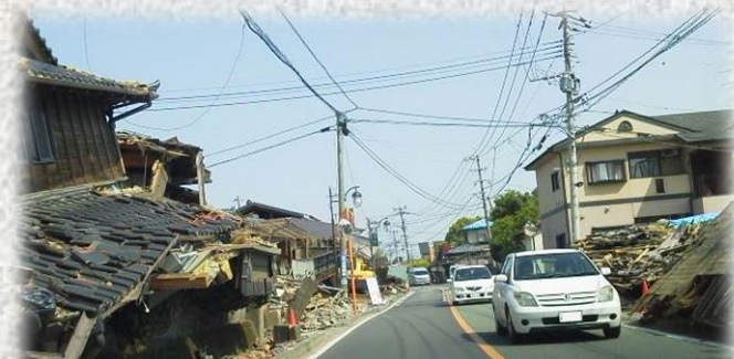
熊本県益城町の被災状況
