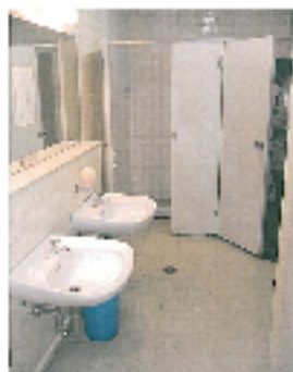
改修前トイレ
