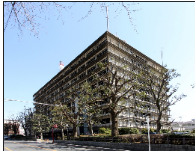
外部 補強 北西側
