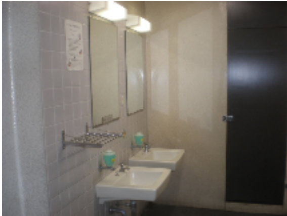
男性用トイレ改修前
