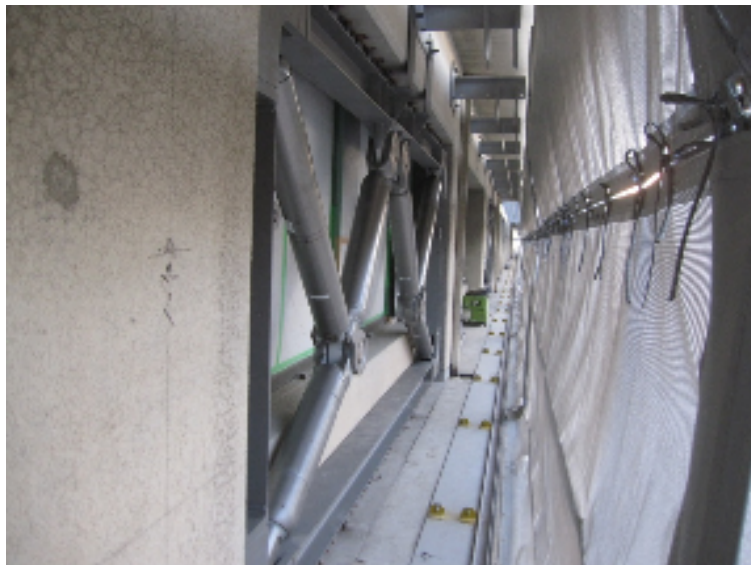
制震ダンパー搬入・取付
