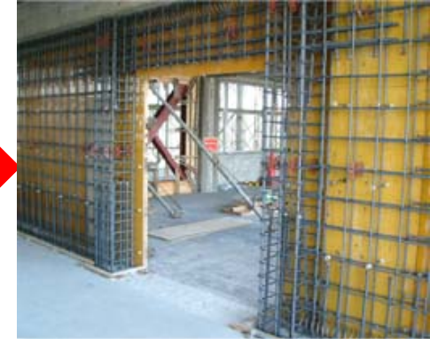
②アンカー設置後、鉄筋配筋
