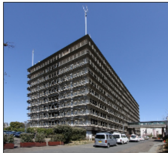
外部補強後 南西側
