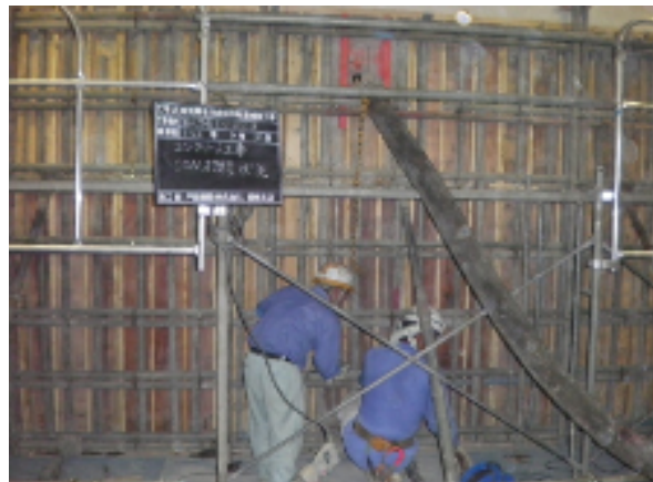
③配筋完了後、型枠組立 コンクリート打設
