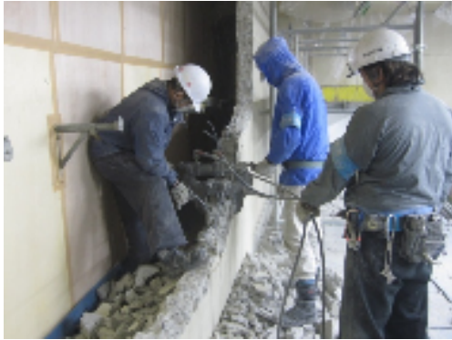
①壁解体後、四方に 後施工アンカー打設
