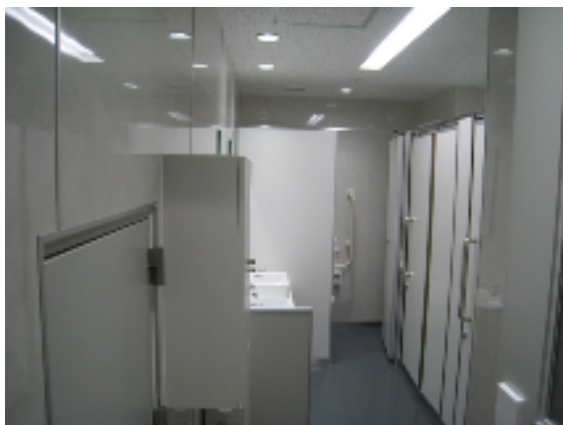
女性用トイレ改修後
