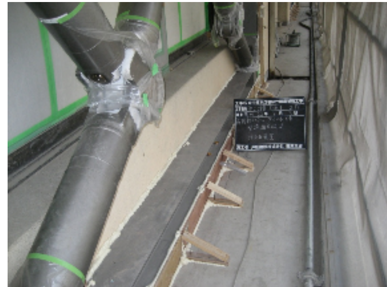
制震ダンパー周囲高靱性モルタル充填
