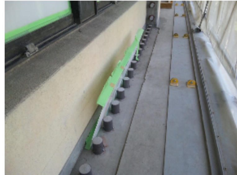
制震ダンパー取付用下部レールセット
