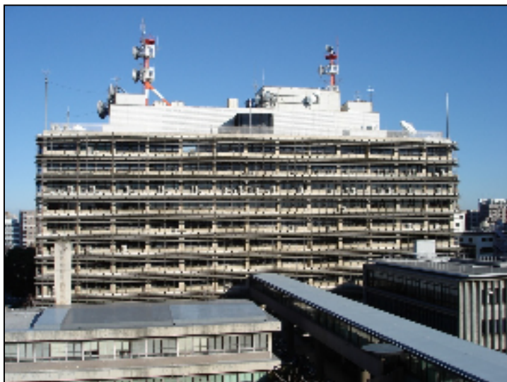
外部 補強前 南側
