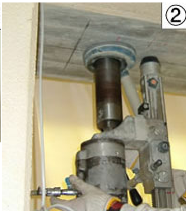
②③調査完了後削溝作業を行い、鋼管コッターを挿入し、接着固定する
