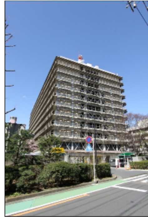
外部補強後 東側
