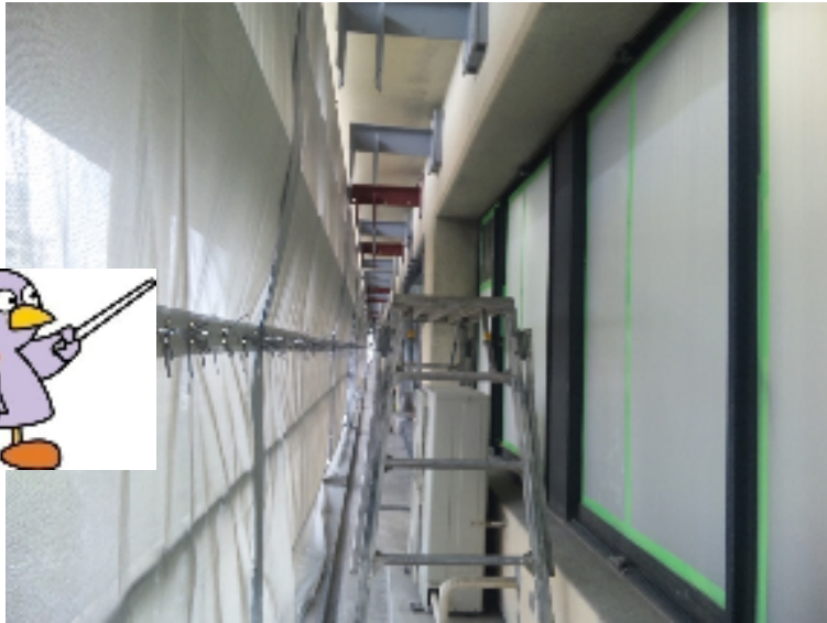
制震ダンパー取付用上部レールセット
