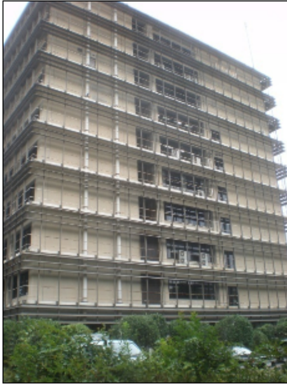
外部 補強前 西側
