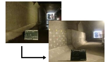
中継ポンプ場耐震工事 (壁部分等の補強)
