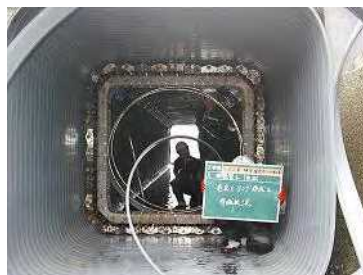
管更生による管渠の耐震化
