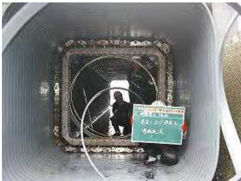
管更生による管渠の耐震化
