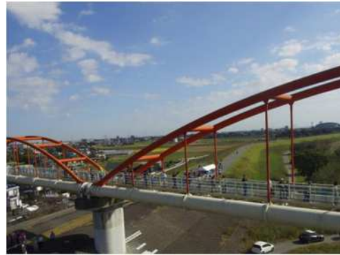
荒川水管橋見学会
