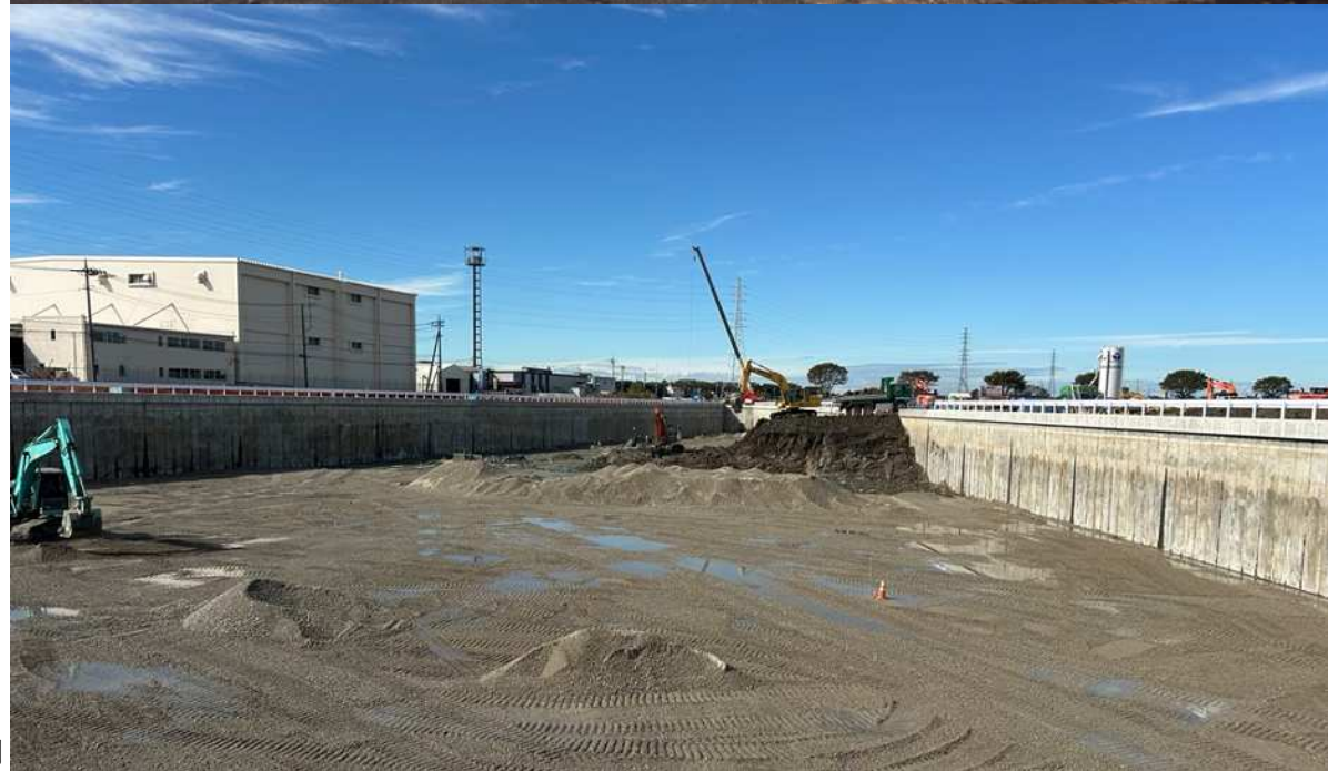
調整池工事における 再生砕石の活用
