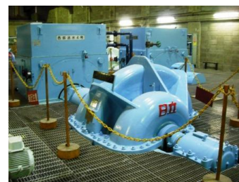
インバータ装置(上)と 送水ポンプ(下)
