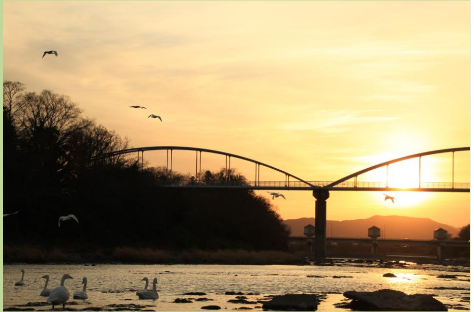
荒川第二水管橋
