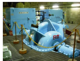
インバータ装置(上)と 送水ポンプ(下)
