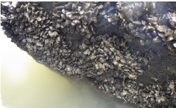
図3 カワヒバリガイの消波ブロックへの固着
