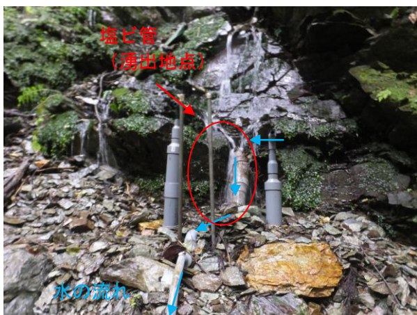
湧出地点（近景） 塩ビ管が岩肌に埋め込まれている
