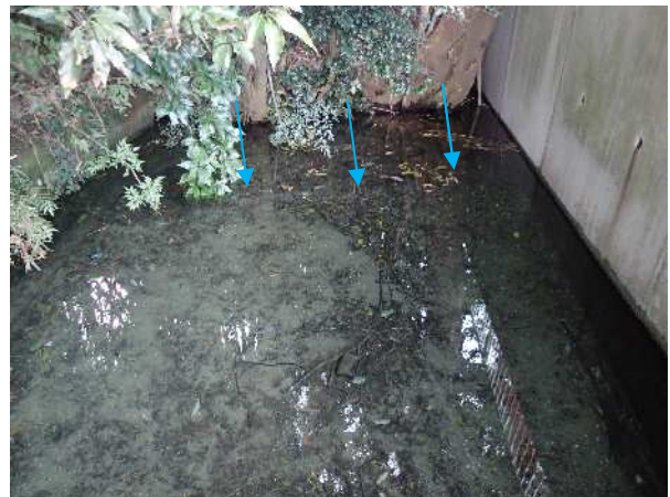
奥の斜面から湧出している
