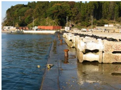
②地盤沈下により冠水した漁港岸壁(H27.10月)
