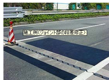
<橋梁のジョイント部段差補修施工例>
