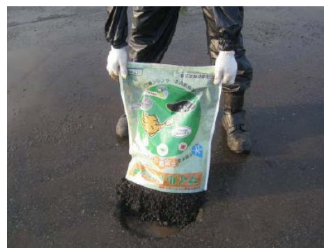
<水溜りでの施工状況>
