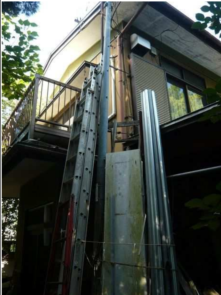
↑ 南東側から撮影（居宅）
