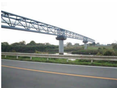
中川の景観(中川水管橋)
