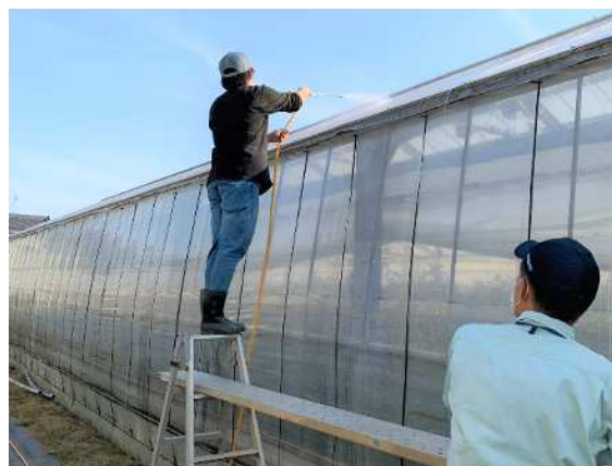
花植木品質改善技術の実証（遮熱資材の塗布作業）
