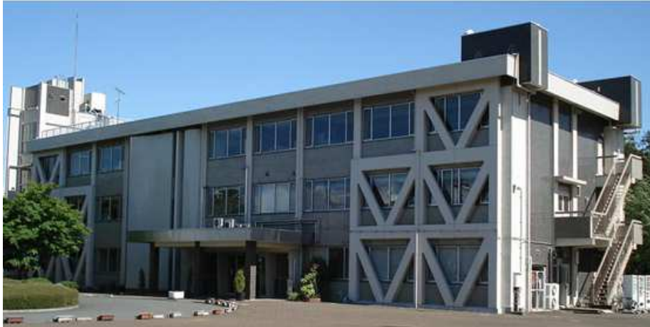
農業技術研究センター本所（本館）
