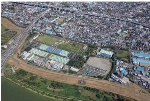
荒川水循環センター（戸田市）
