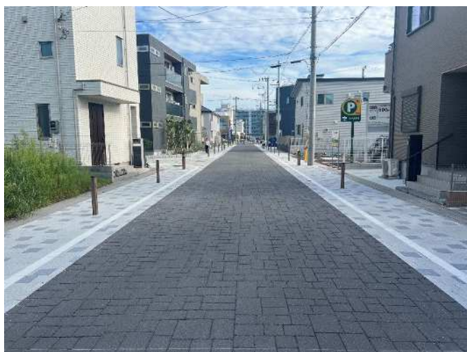
土地区画整理事業 (草加市 新田駅東口地区)
