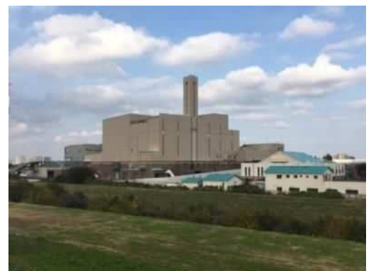
ごみ焼却ごみ処理場 (さいたま市新クリーンセンター)
