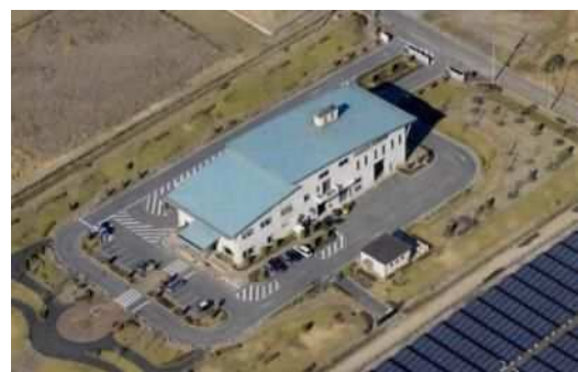
汚物処理場 (羽生市汚泥再生処理センター)
