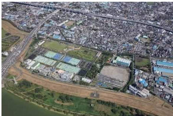
荒川水循環センター（戸田市）
