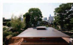
雨降の日にすべりと覆われるような佇まい。屋根には薪や炭や木の灰が落ちることも、雨樋は取り付かず、雨水はそのまま地面に浸透する。外壁には建主さんが愛した杉板を張った。
