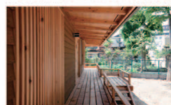
1.5m出た軒が雨の外壁と浮き回廊を守っている。木材は製造、廃棄過程でのエネルギー消費も少ない優秀な材料であるが、とにかく水に強い、水との接触を減らすことが長寿命にもつながる。
