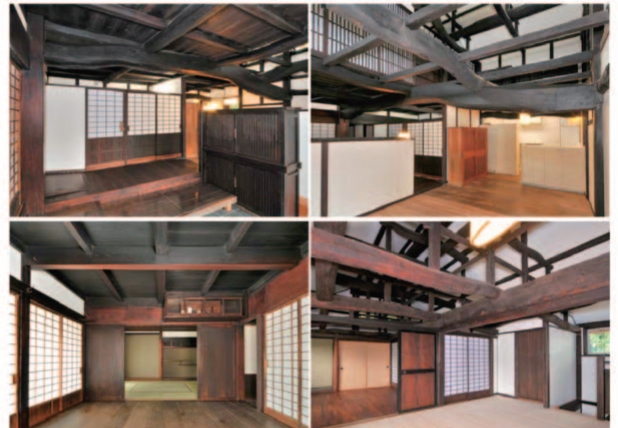
A 玄関から上間に入ると1尺角ケヤキの大黒柱、曲がりの強い長大な半梁が架かる。正面建具は当初の障子転用 B 玄関上手にある元の茶の間、板の間に差込で応接室とした。奥は床の間 A～B竣工写真撮影：小野吉彦 C リビングダイニングに変わった土間ニワの空間、二階床を外すと吹き抜けの大空間が現れた D 二階屋を使って二階に設けたラウンジ。ここを中心に左側の主寝室、便所、右側の階段、小箱組が見通せる
