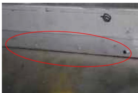
HEPA フィルタ取り付け面
