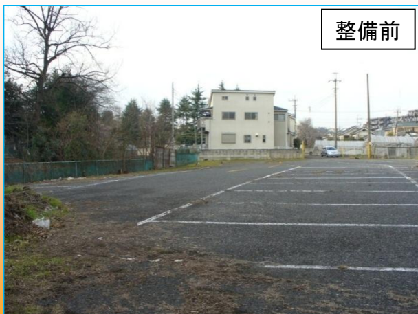
水辺へのアプローチがない(H22.4撮影)
