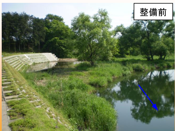
護岸前面の水際部侵食(H20.4撮影)
