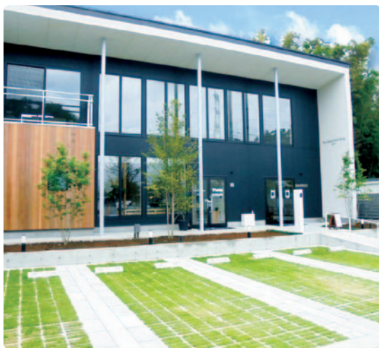
駐車場の緑化(鶴ヶ島市)
