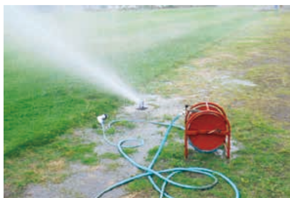
【表面散水装置】(ポップアップスプリンクラー)
