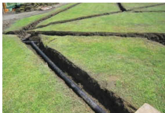
【地下浸透管設置】
