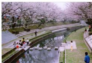
元荒川の親水護岸の整備（吹上町）
