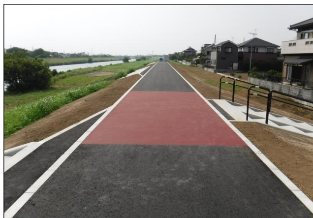
元荒川の遊歩道の整備（越谷市）
