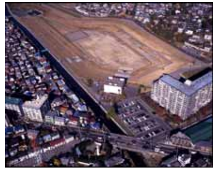
上谷沼調節池
