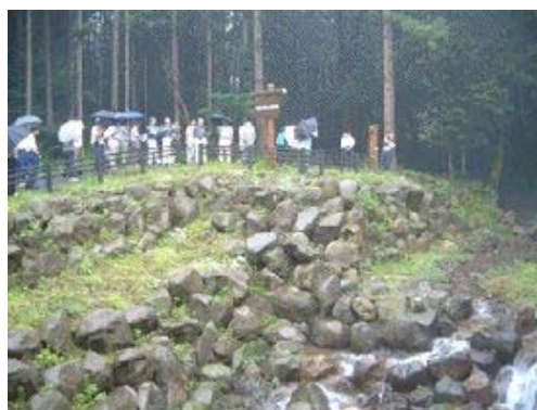
寺沢川ふるさと砂防整備について説明を受ける 荒川みらい会議のメンバー
