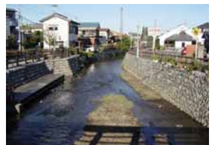
新河岸川上流の川越市内では、親水護岸の整備が行われている
